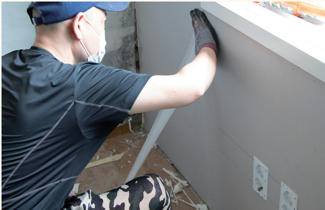
도배 후 석고보드 이음매 부분이 드러나지 않도록 전용 테이프를 이음선을 따라 평탄하게 붙였다.
