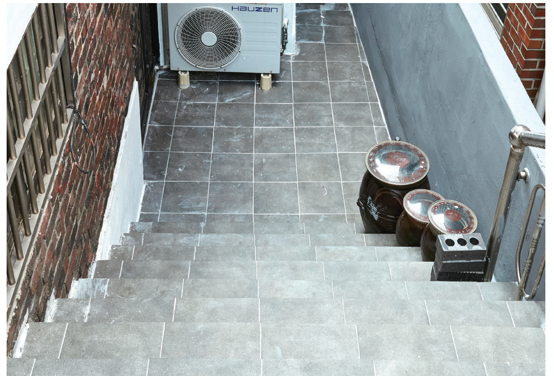
지층 주거로 이어지는 외부계단의 타일을 교체한 모습. 계단을 오르내릴 때 위험했던 깨진 타일들이 안전하게 정리되었다.
