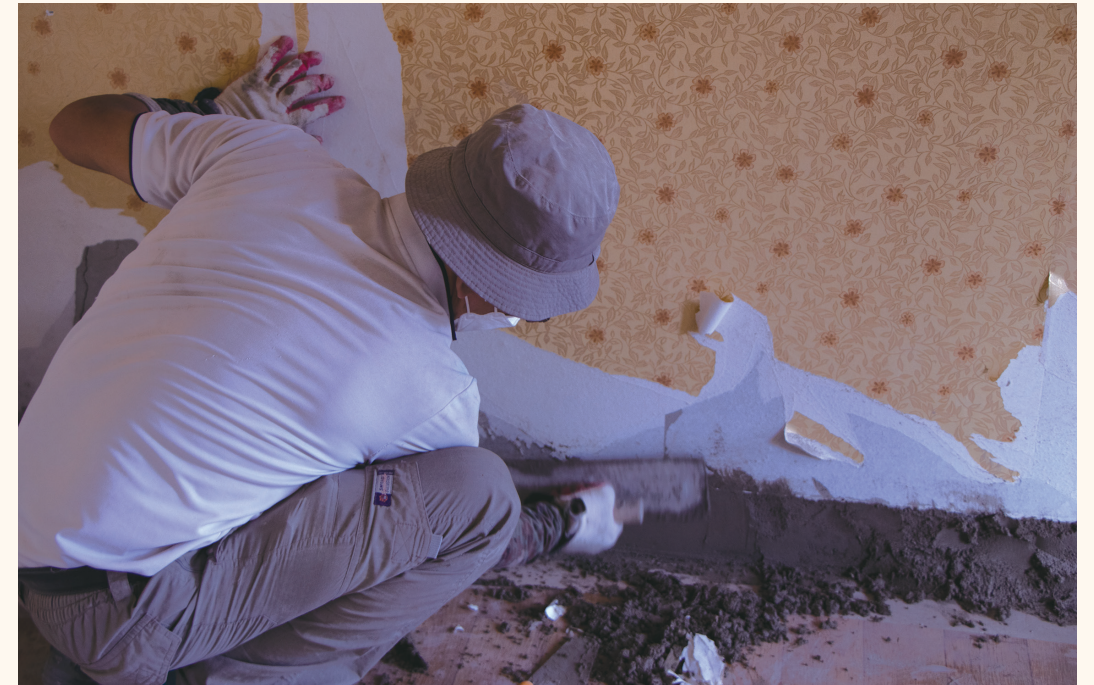
걸레받이를 떼어낸 부분의 벽면 미장 상태가 고르지 않아, 다시 미장하여 고른 면을 만들어 주었다.
