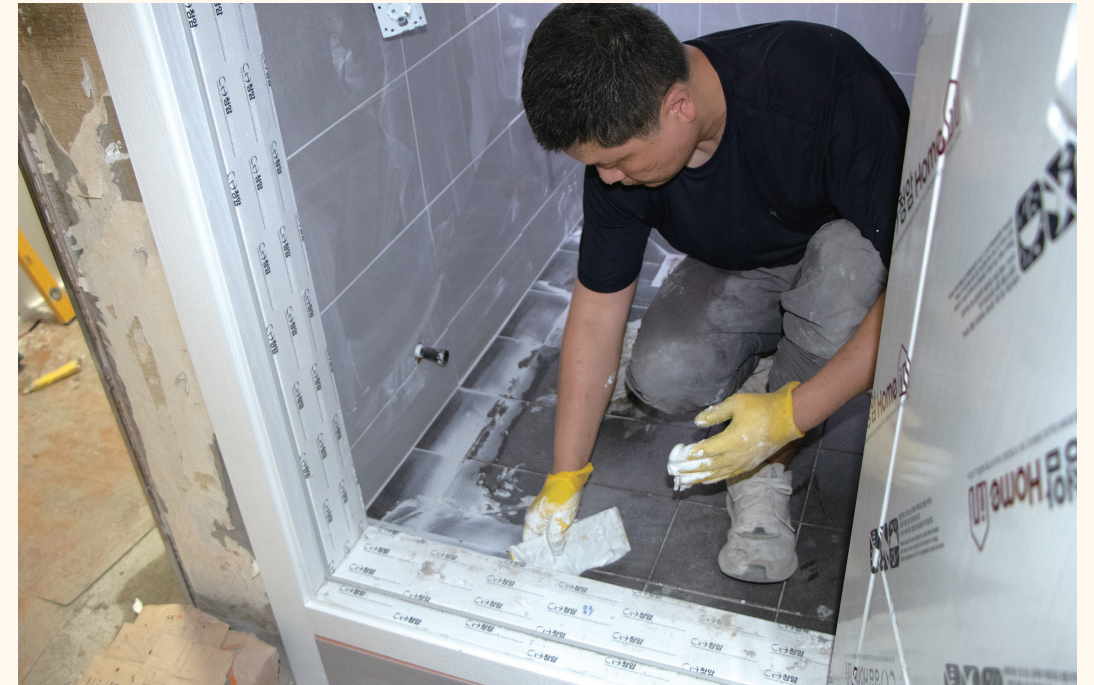
화장실 타일의 줄눈 시공 모습
