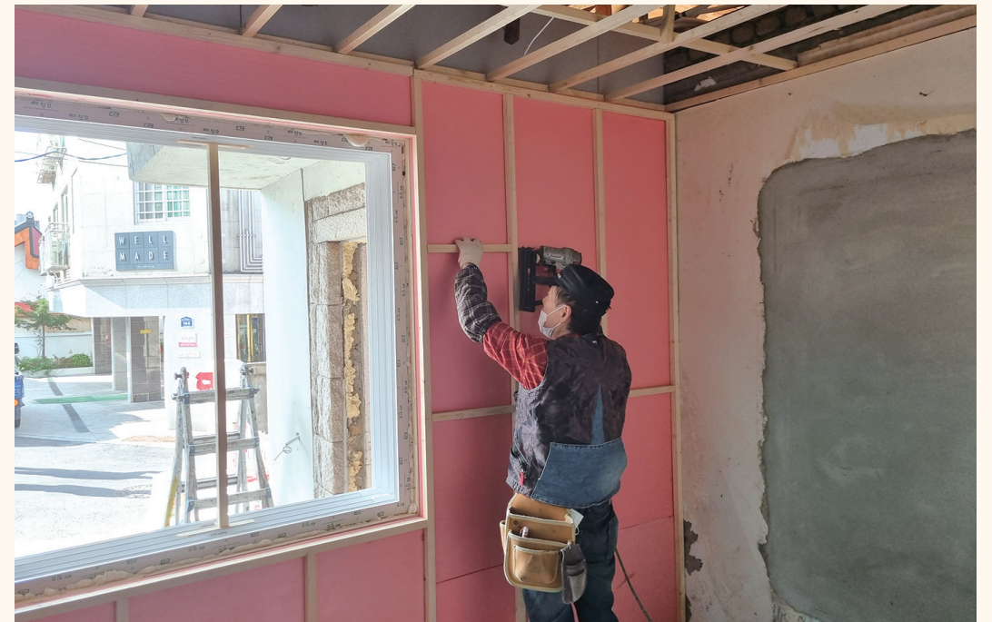
벽면에 단열재를 빈틈없이 부착한 뒤 목재틀을 설치했다.
