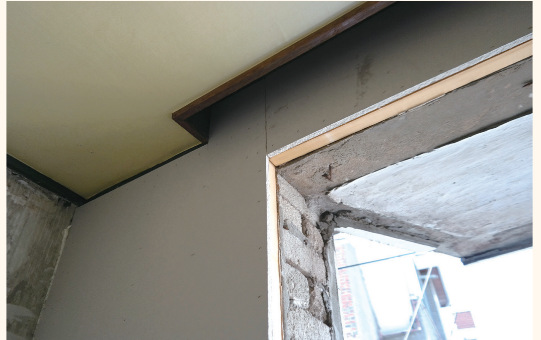
석고보드 마감 작업이 완료된 모습
