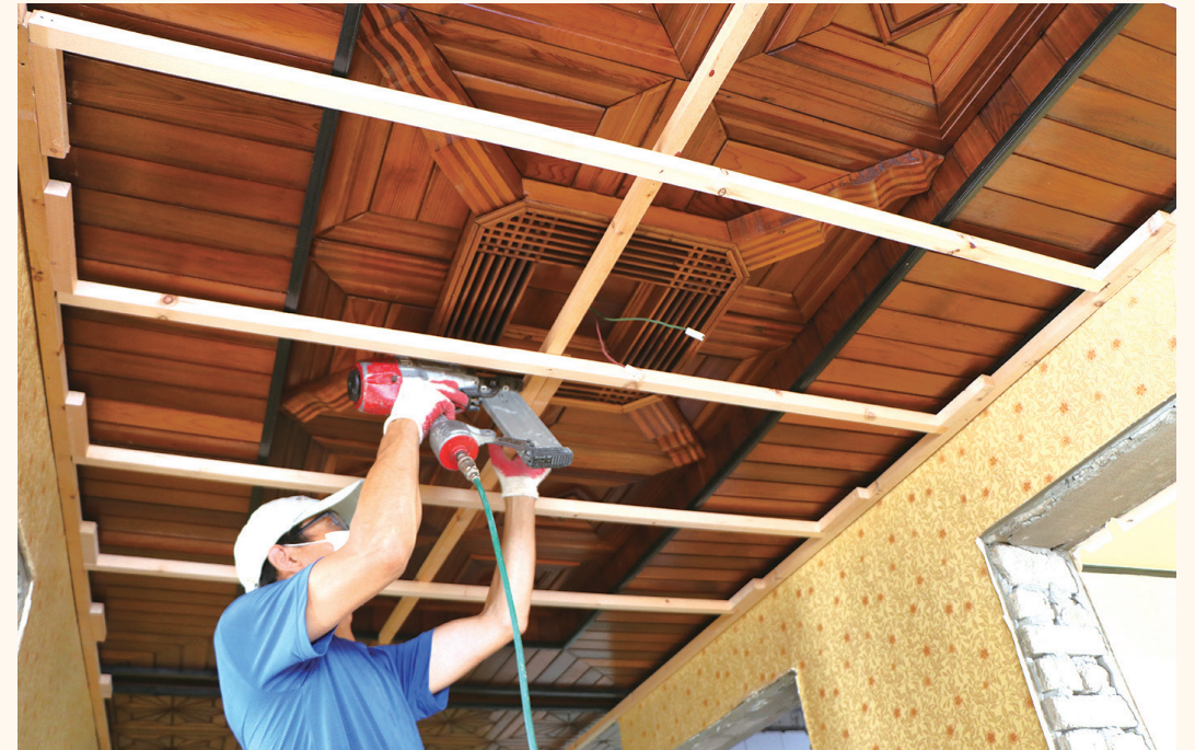
천장에 새로운 반자를 대기위하여 구조틀을 만들고 있는 모습
