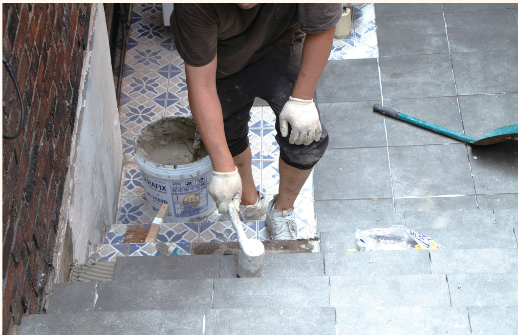
평활한 계단 면을 위하여 타일 부착후 고무망치로 두드려 높낮이를 맞췄다.
