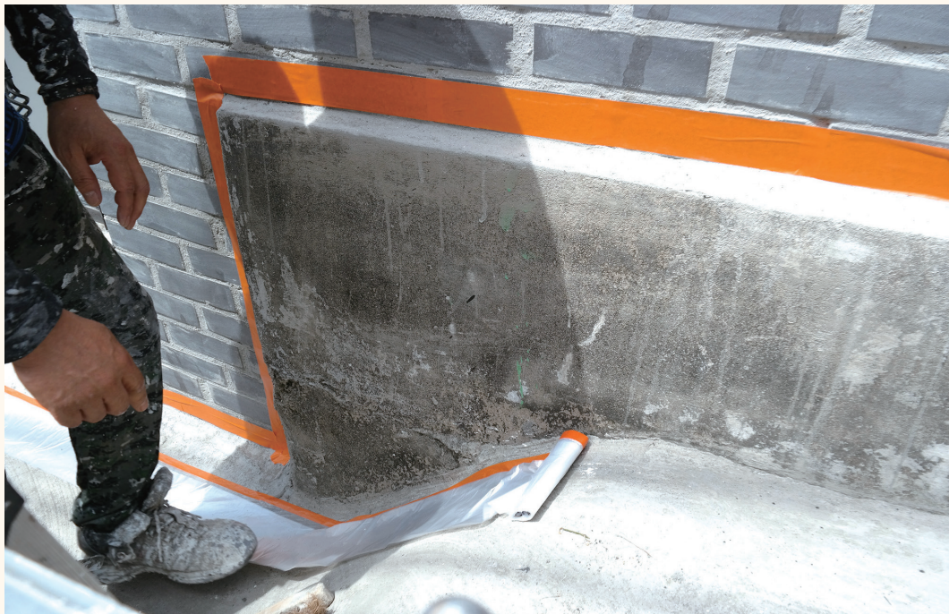
경계 부분을 깨끗하게 도장하기 위하여 도장작업 전 미리 보양재를 설치하는 모습
