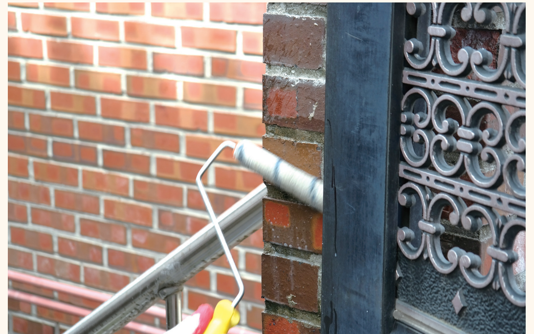
좁은 벽돌 면에도 발수제를 도포하는 모습. 벽돌이 충분히 적셔지되, 흘러내리지는 않을 정도로 도포한다.
