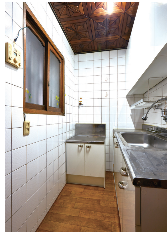
화장실과 주방의 집수리 전후 모습. 화장실 급수관을 교체하면서 세면대를 신설했다. (화장실 위생기구와 주방공사 자부담 별도 추진)
