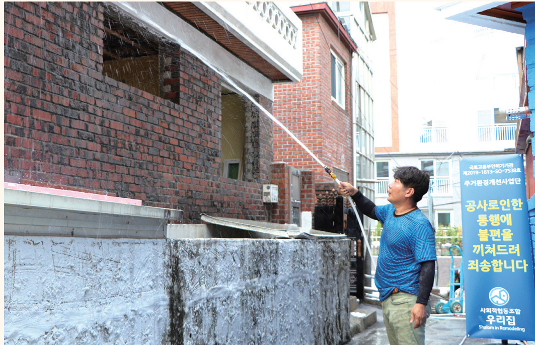
고압 호수로 외벽에 오염된 이물질질을 세척하는 모습
