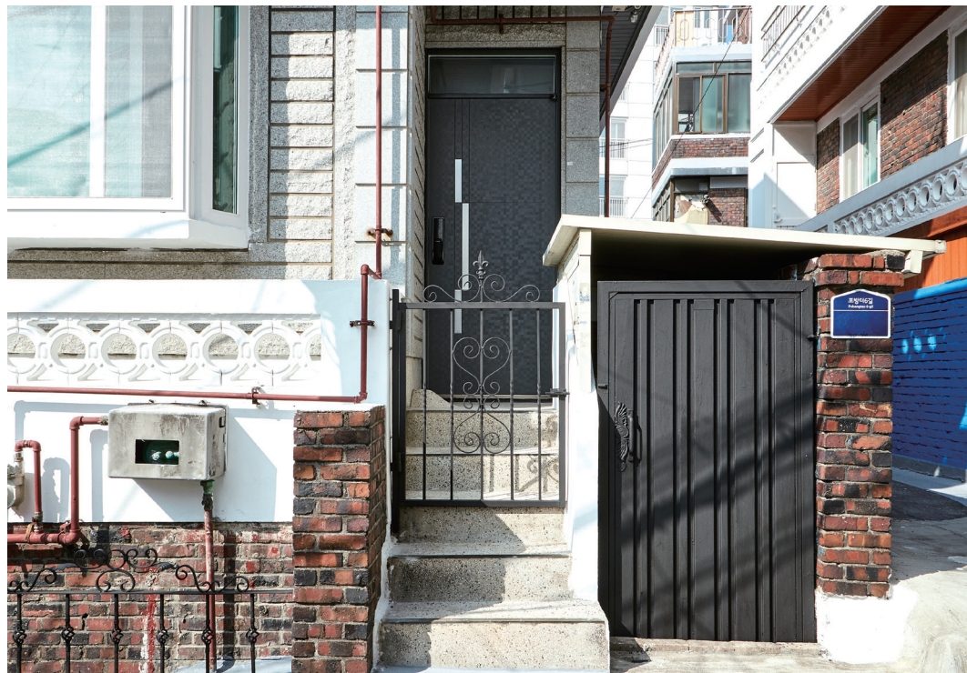
세대 출입문과 현관문을 교체한 모습. 현관문 교체로 단열성능이 좋아졌다.
