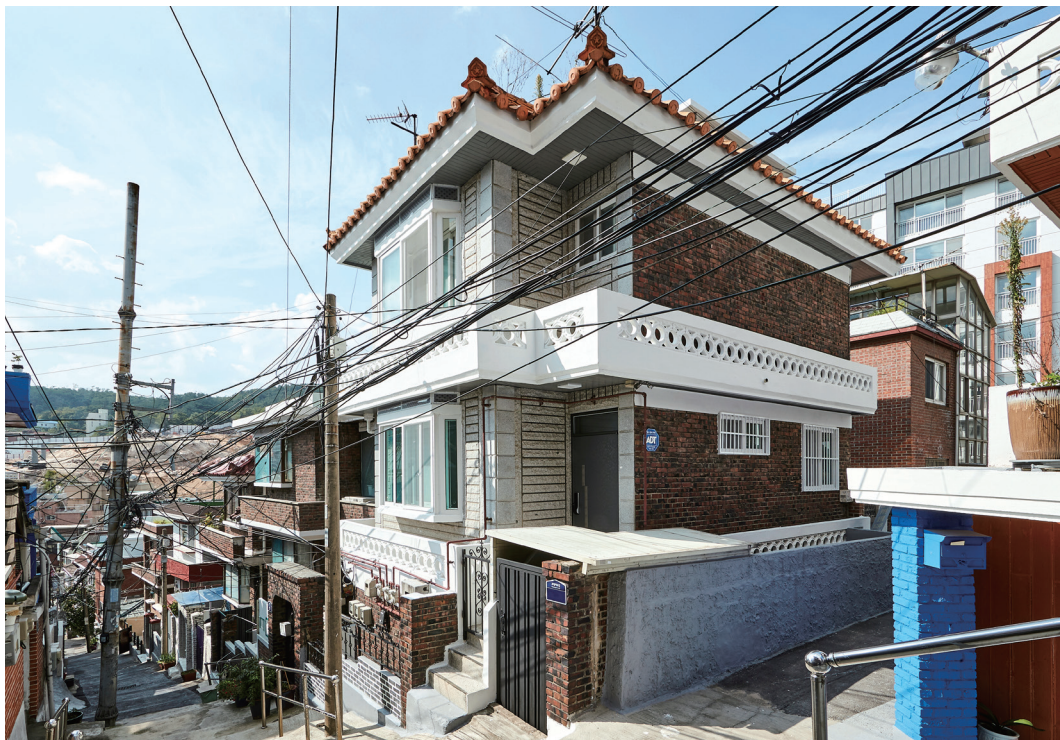
공사전·후 주택의 전경. 외벽도장, 창호교체, 담장 재조성으로 한층 깔끔해진 모습이다.
