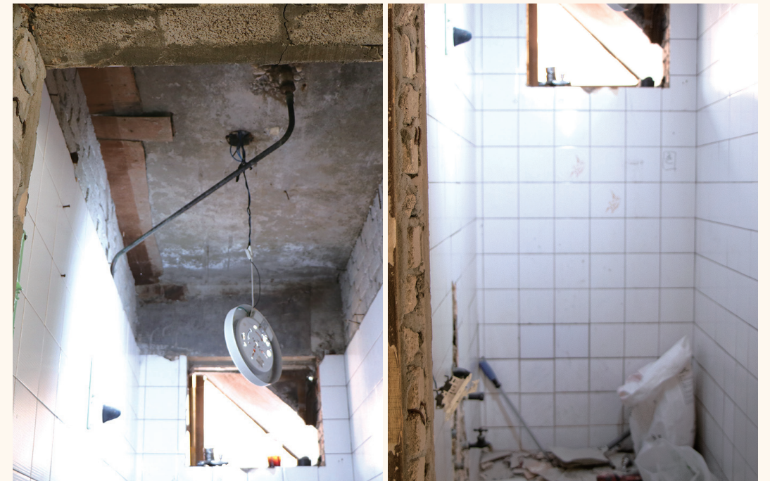
화장실의 위생기구와 천장은 모두 철거하였고, 벽면의 타일은 부착 상태가 양호하여 새로운 타일을 덧붙여 시공하기로 했다.
