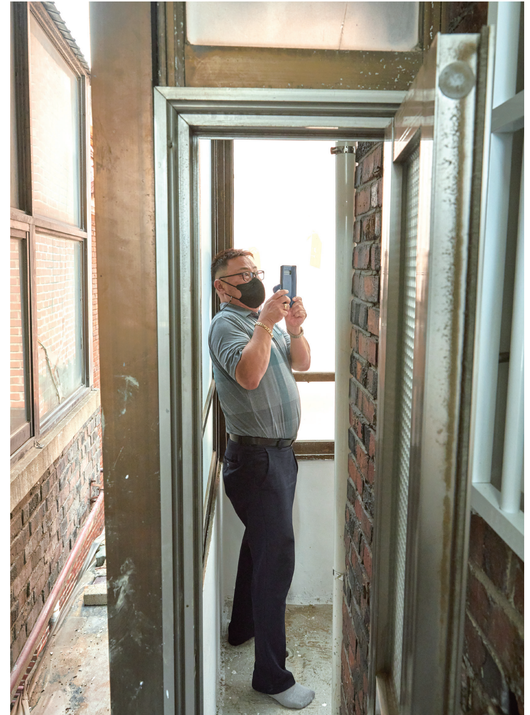
이문재 건축사는 서울가꿈주택사업 현장 점검자로서 견적이 적절한지, 시공이 잘 되었는지 판별한다.
