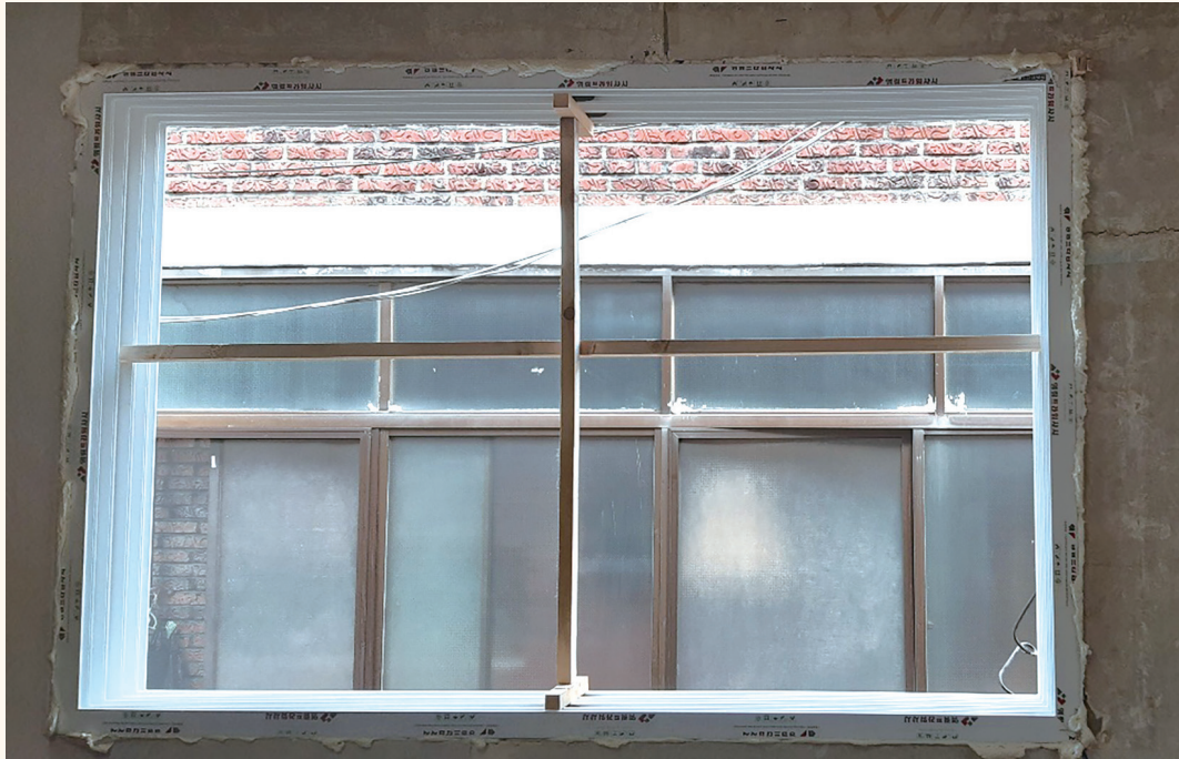
우레탄 폼이 충분히 건조될 때까지 창틀이 움직이지 않도록 고정해 둔 모습
