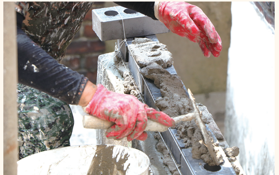
수평을 잡아 실로 표시한 선에 맞춰 벽돌을 쌓아올리는 모습
